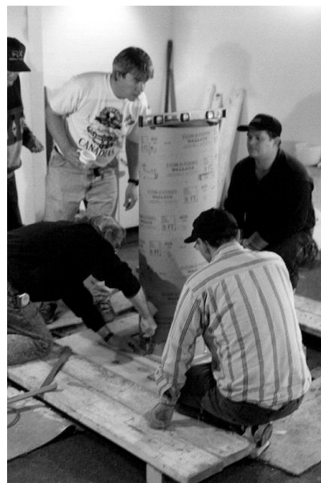
Pouring the concrete pier.
